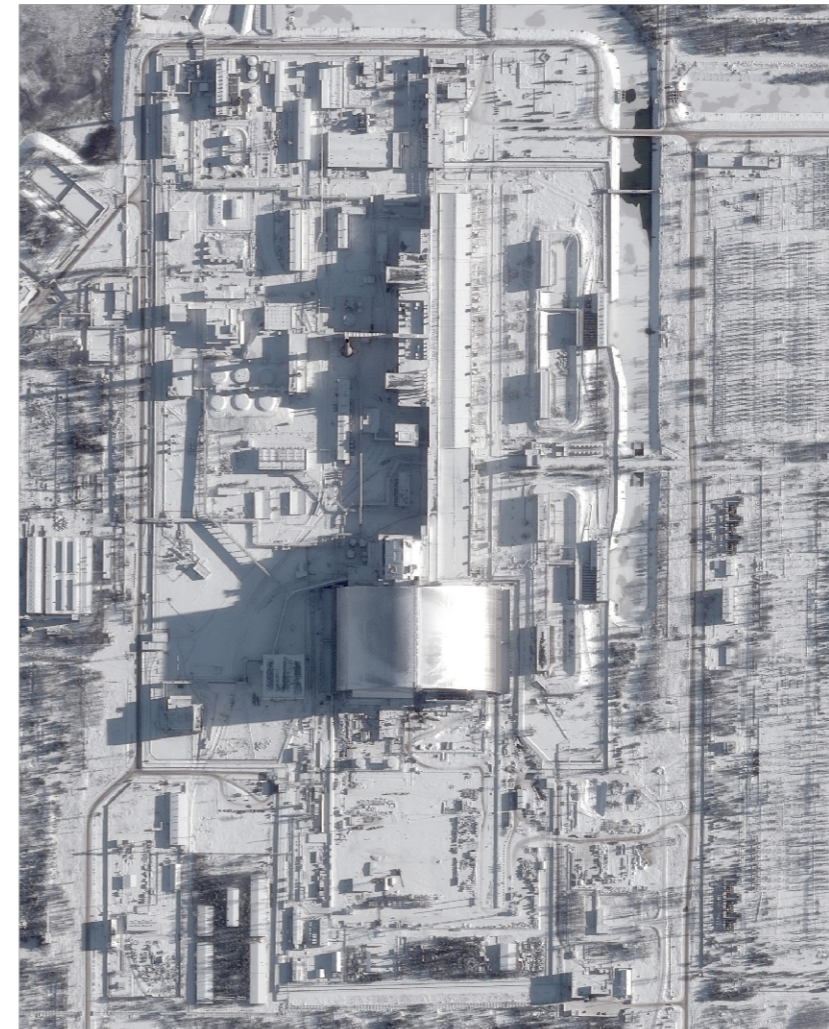
L'arche installée sur le réacteur 4 de la centrale de Tchernobyl. Image acquise par le satellite Pléiades en décembre 2016.
